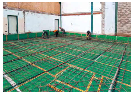
Fundament Bürogebäude, Romano d'Ezzelino Vicenza.
